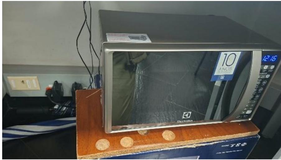
Evidencia fotográfica 1. Equipos de consumo general conectados a circuitos destinados al soporte de infraestructura tecnológica.
