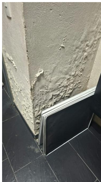
Evidencia fotográfica 6. Imágenes del cuarto técnico de la Sede Campus Nueva Granada evidenciando humedad, filtraciones y exposición de componentes técnicos a suciedad, corrosión, cortocircuitos, y daño físico.
