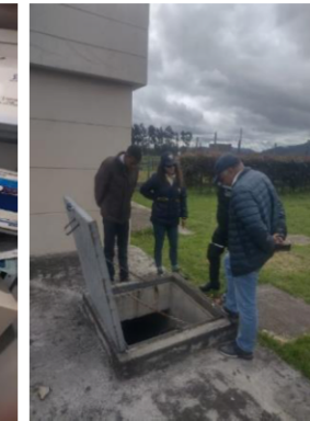
Seguimiento de tanques de agua potable
