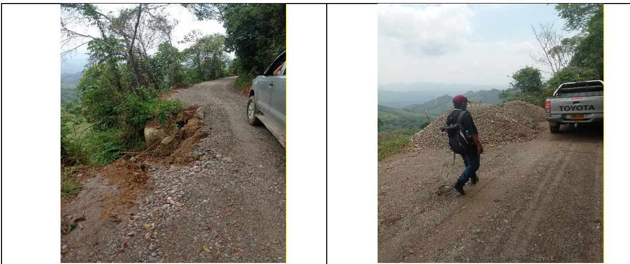
Foto punto para construcción de alcantarilla y muro en gavión.
