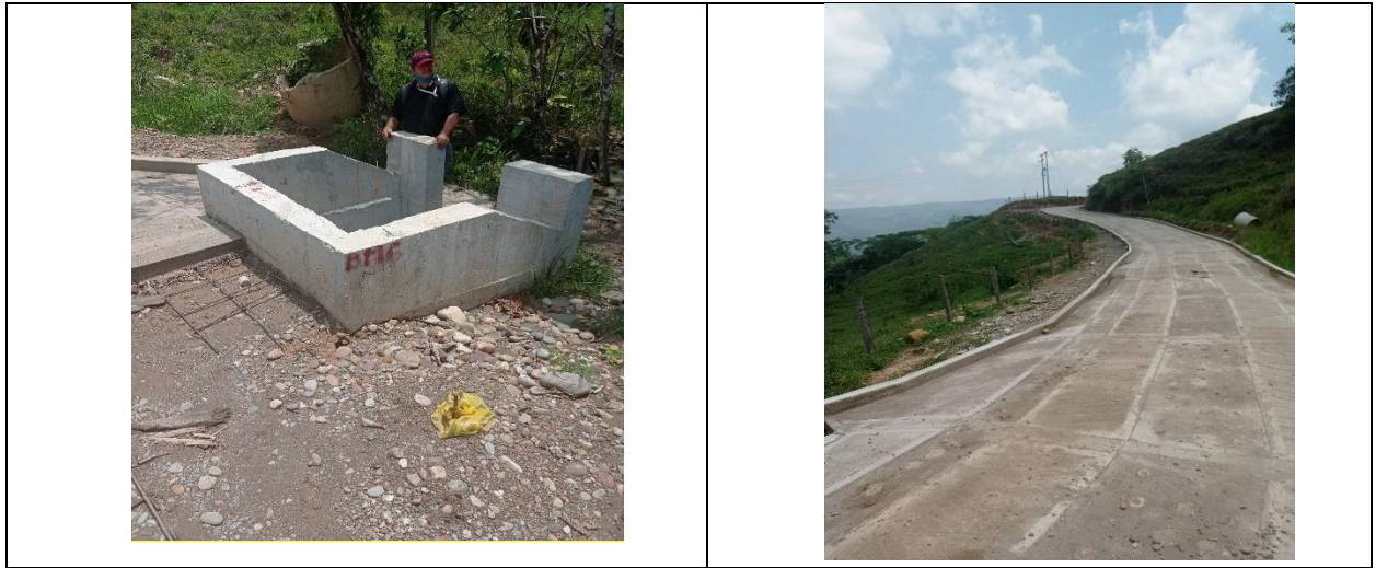
Foto inicio de placa huella en concreto
