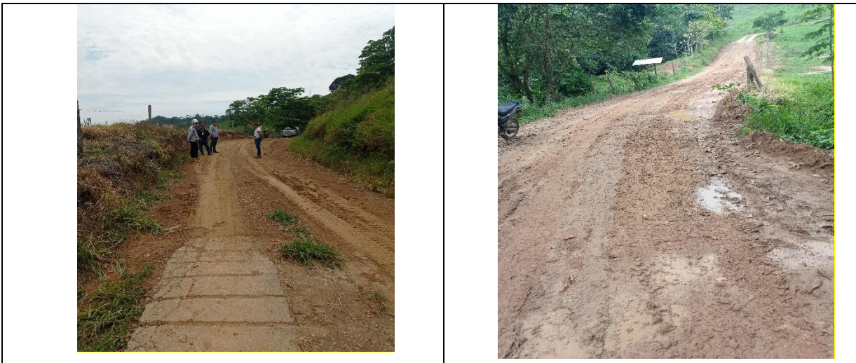
Foto inicio de los tramos
