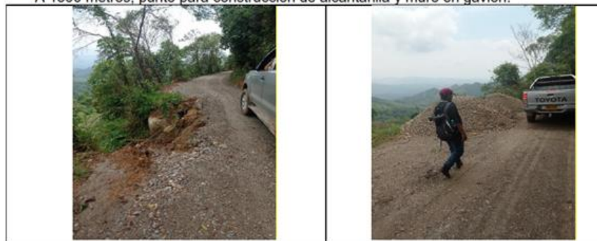
Foto punto para construcción de alcantarilla y muro en gavión.
