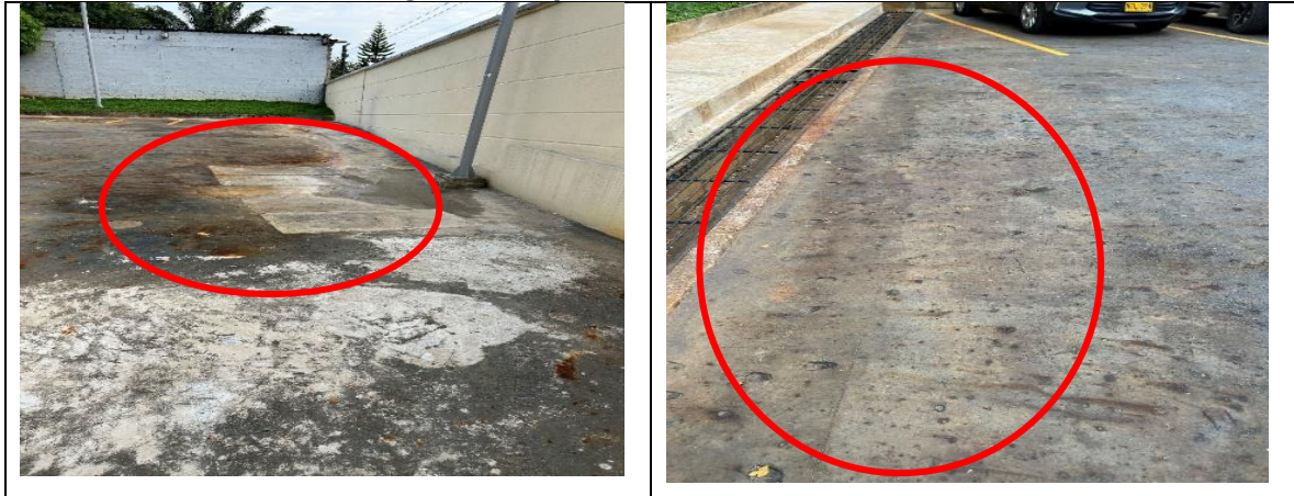
Imagen: Parqueadero del laboratorio.
