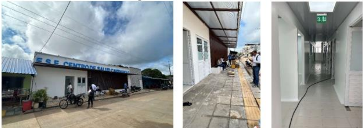
Imagen Parte exterior de la ESE.
