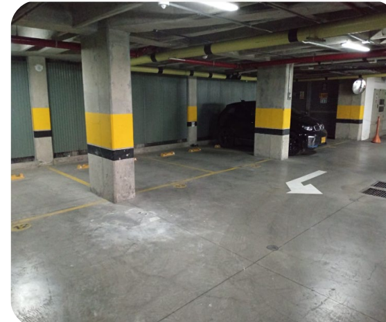
P. SEDE POSGRADOS
